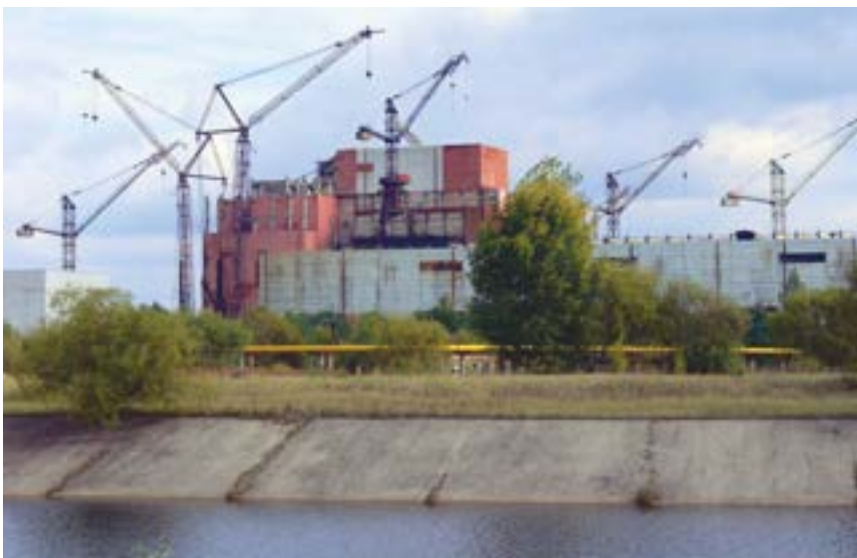
Третя черга ЧАЕС – недобудовані 5 та 6 енергоблоки
