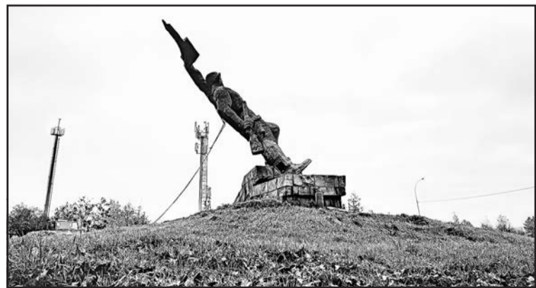
▲ 9.11. 2022 р., як і планувалось, в Ужгороді демонтували монумент, який має офіційну назву «Україна-Визволителям». Рятувальники прив'язали його тросом, підпиляли основу та потягнули.
